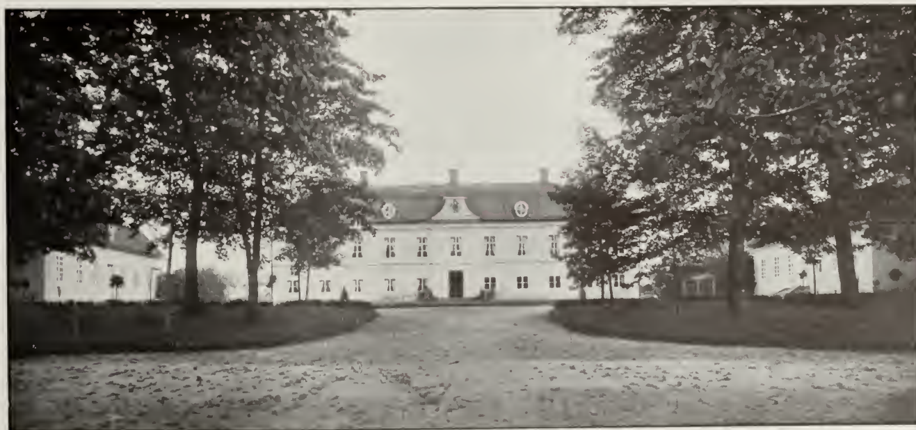
Hufvudbyggnaden och flyglarne från gårdssidan.
